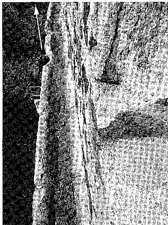
Obr. 14. Radyně, hrad, třetí podlaží západní věže, odkouření krbu do fasády. Foto J. Anderle, 2006. – Abb. 14. Radyně, Burg, drittes Geschoss des Westturms, Rauchabzug des Kamins in der Fassade. Foto J. Anderle, 2006.
